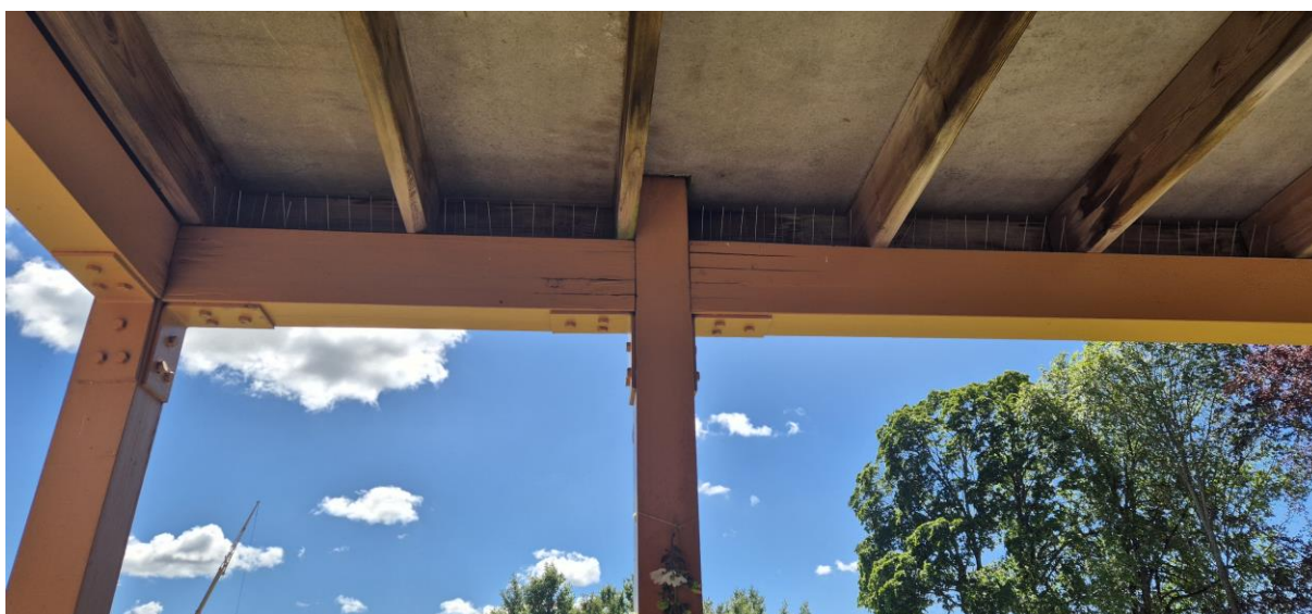
Tett tak mellom verandaene og duepigger. Begge skal reetableres på en god måte.
