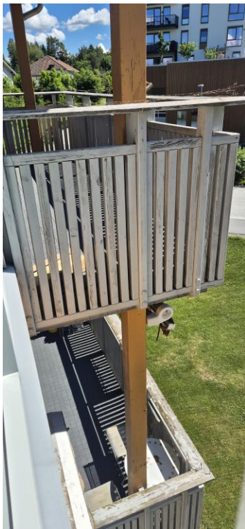
Betydelig råteskade i bærende konstruksjon.
